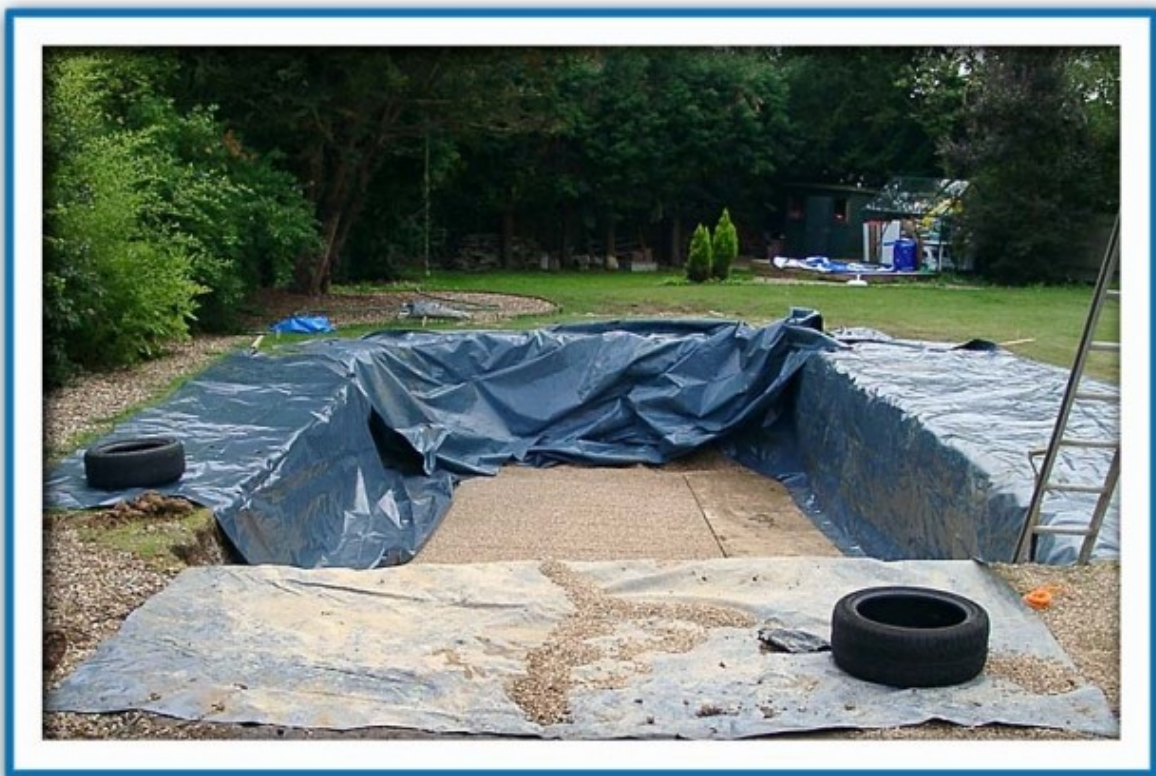
Застелание стен геотекстилем
