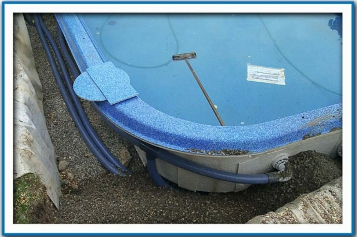
Подготовка к монтажу системы фильтрации
