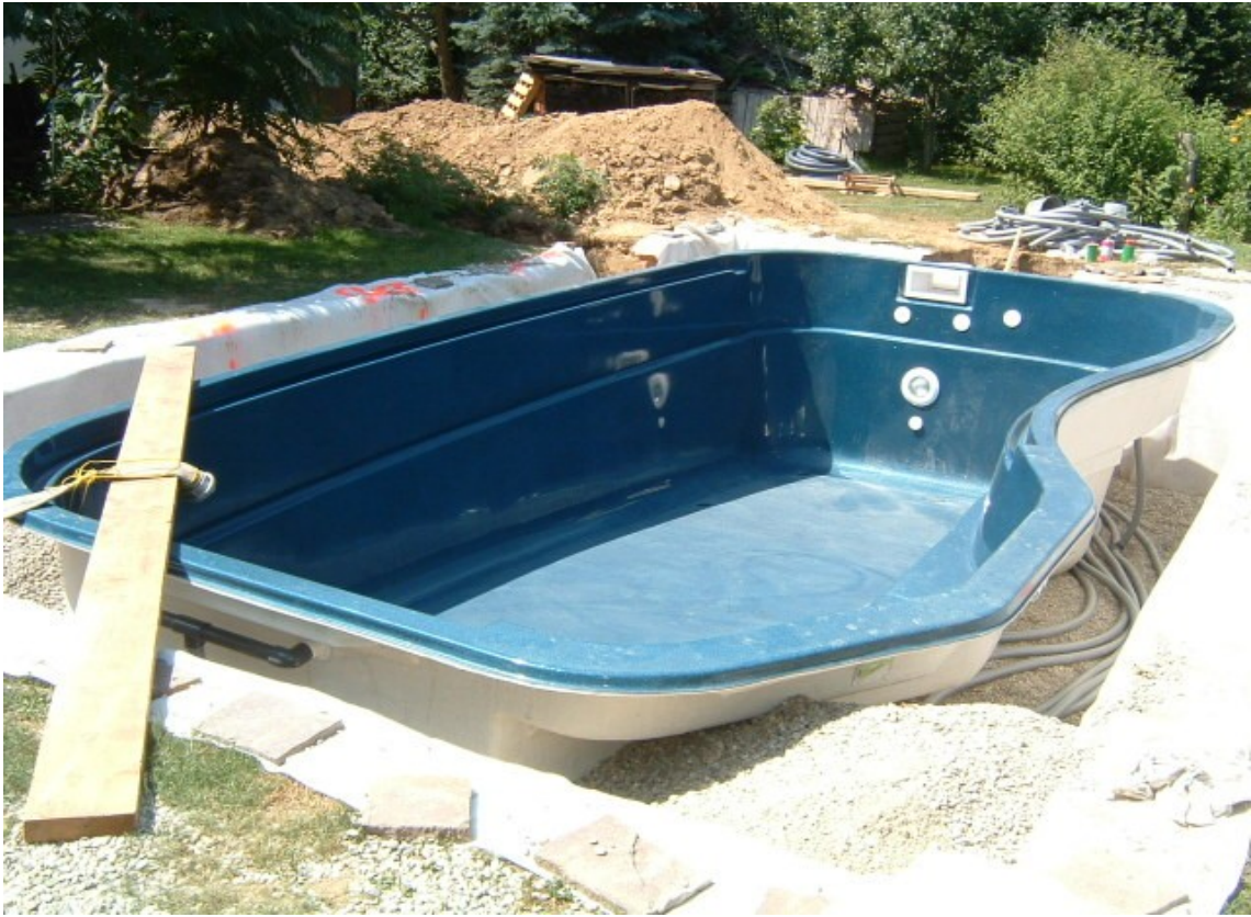
Фиксирование чаши обсыпкой по углам
