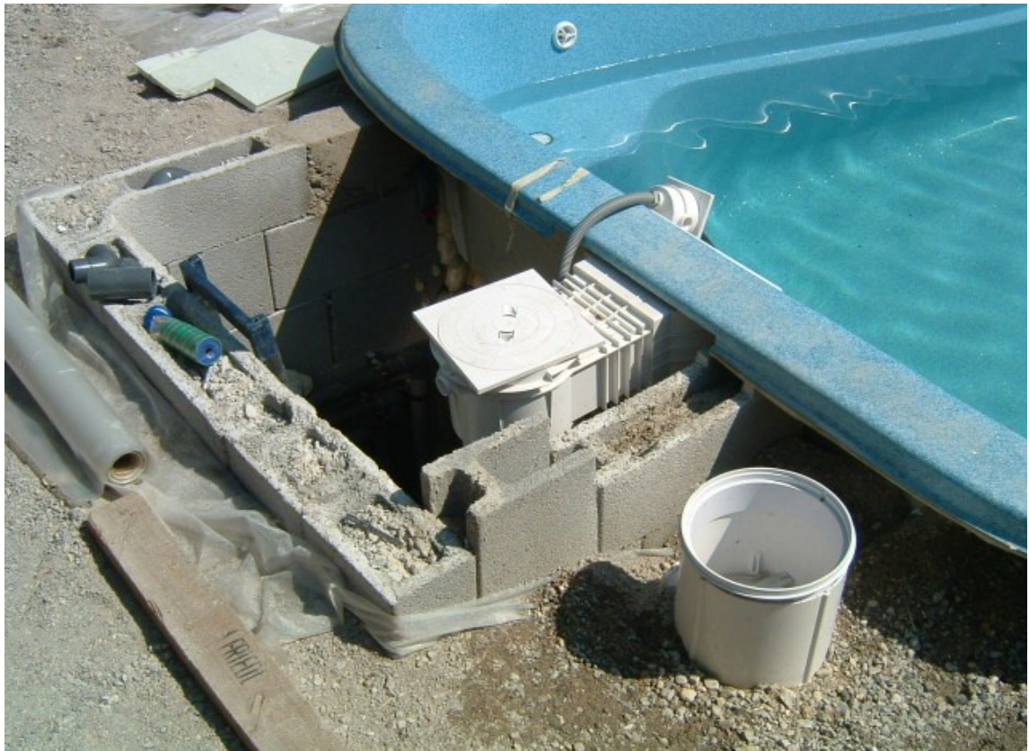
Подготовка к монтажу системы фильтрации
