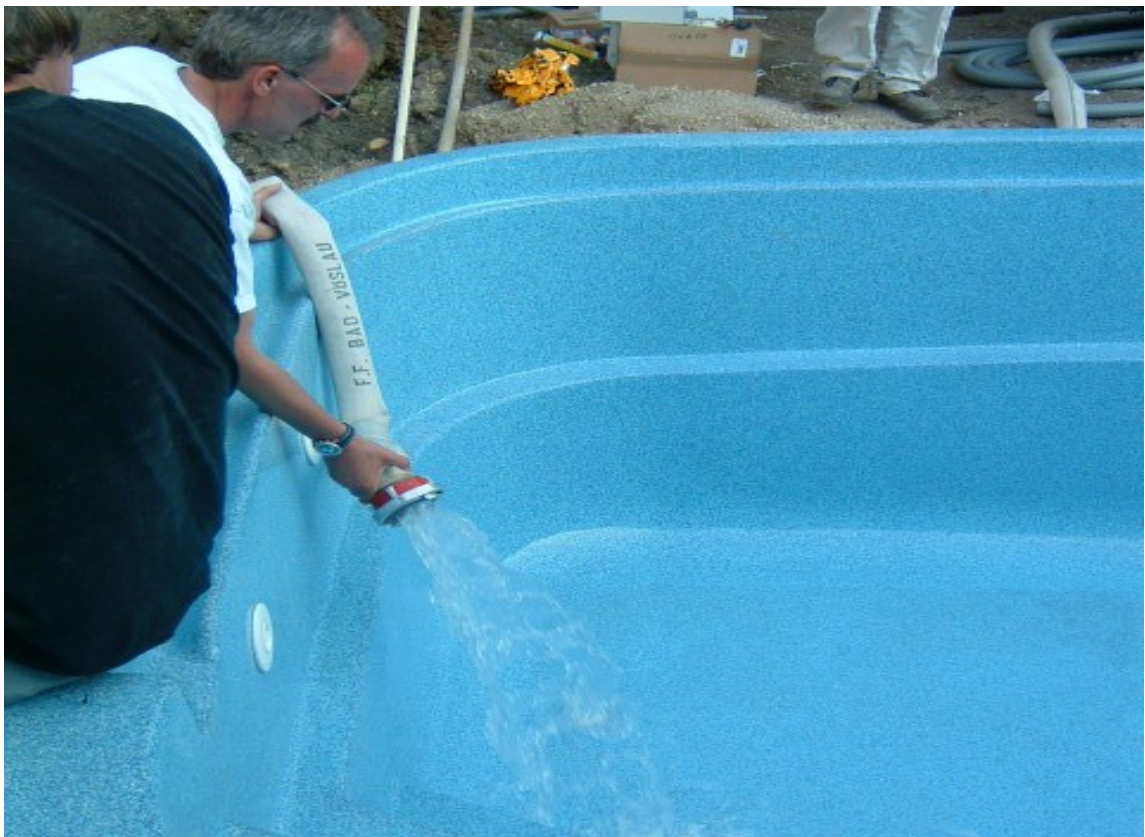
Набор воды параллельно с обсыпкой чаши
